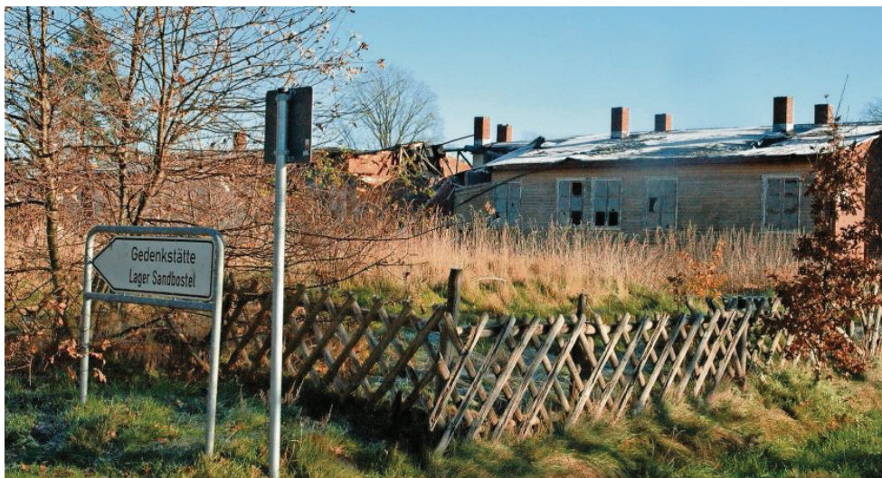
Verfallene Baracken und hohes Gras am Eingang zur Gedenkstätte Lager Sandbostel. Nach dem Kauf des „Edelmanngrundstücks“ soll das rund 15 000 Quadratmeter große Areal hergerichtet werden. Foto Oertel
