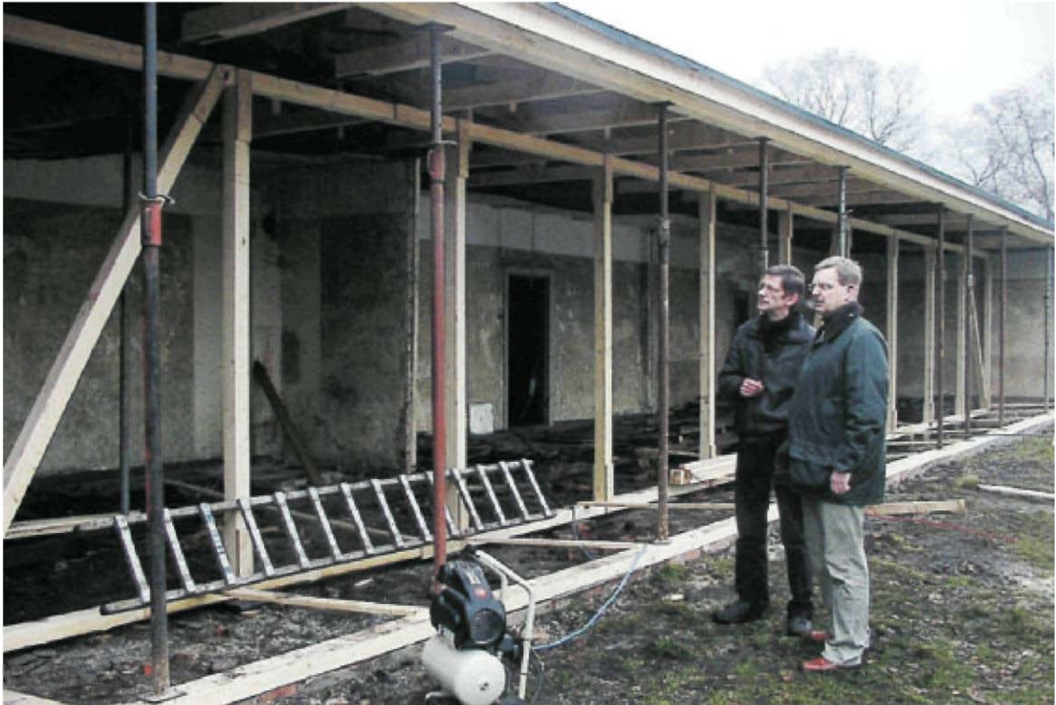
Der Leiter der Dokumentationsstätte Lager Sandbostel, Andreas Ehresmann (links), und der Stiftungsvorsitzende Karl-Heinz Buck begutachten die Bau- maßnahmen an der Baracke Z4. LAFFOTO: LARS FISCHER
